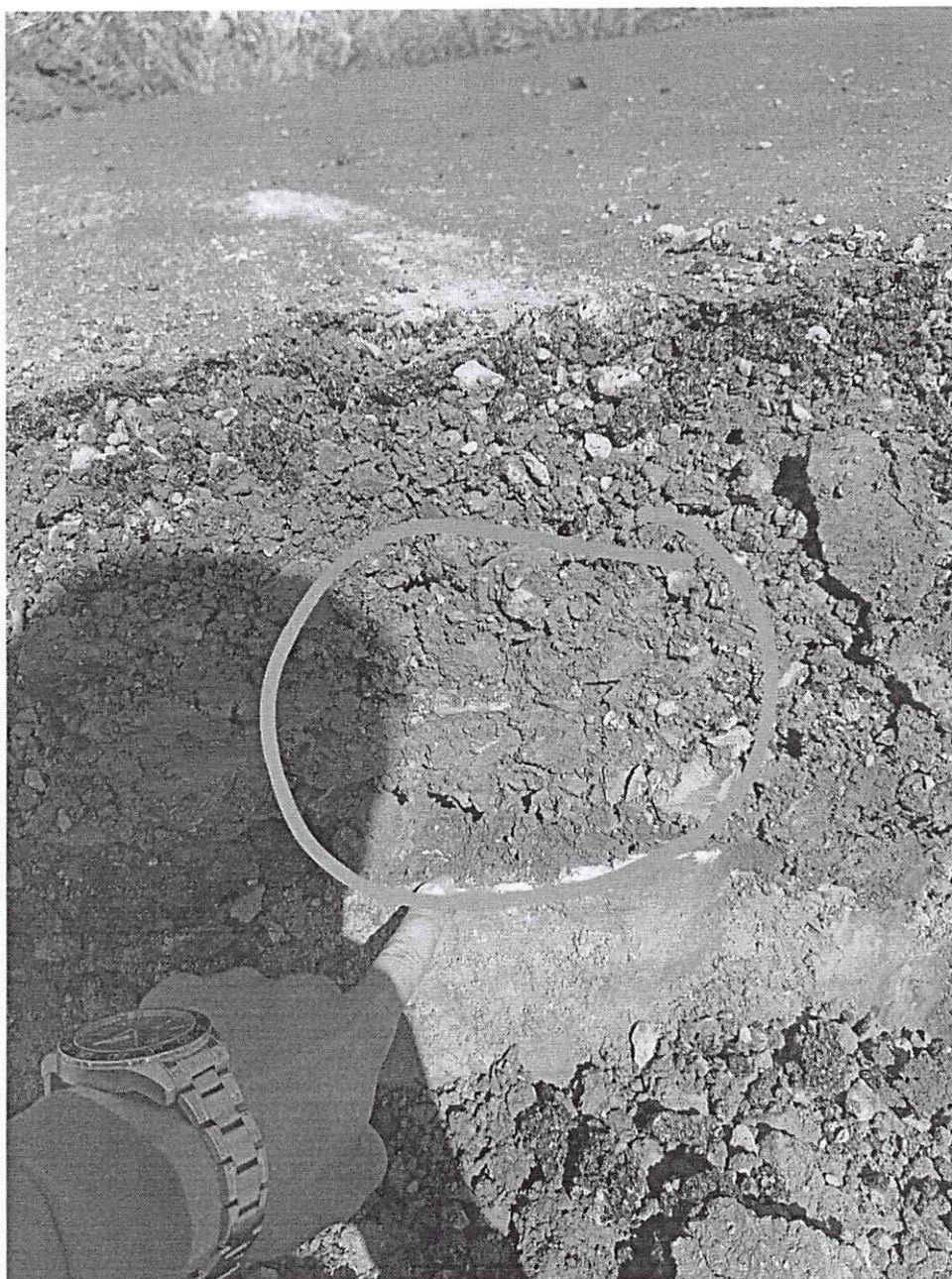
Foto 5: perfil geológico da área onde se executou o recapeamento asfáltico: presença de barro e materiais inservíveis, utilizados como subleito, em áreas que receberiam a BGS e CAUQ, a cargo da Pedreira Santiago LTDA
