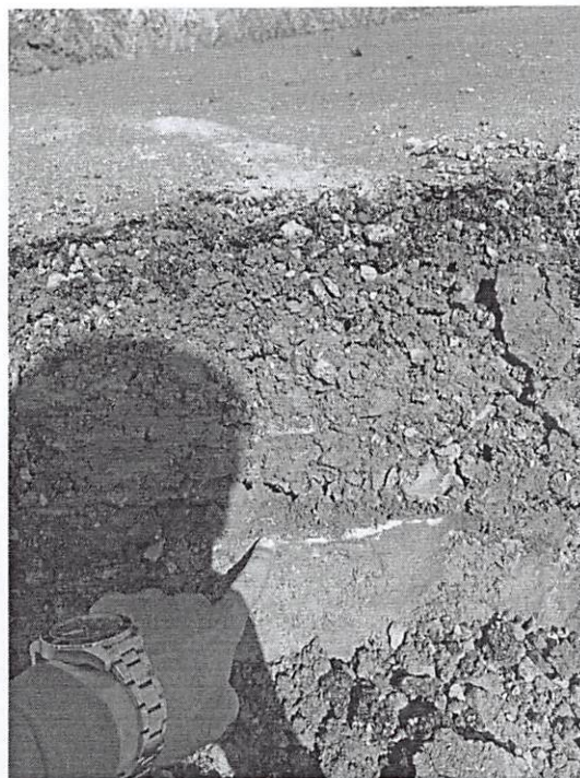
Fotos 1 e 2: perfil geológico da área onde se executou o recapeamento asfáltico. Pode-se ver que não existe uma sub-base composta de materiais adequados para a execução das camadas subsequentes.
